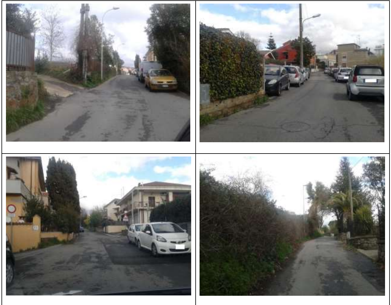
Foto 25: Fontana Sala - la viabilità principale.
