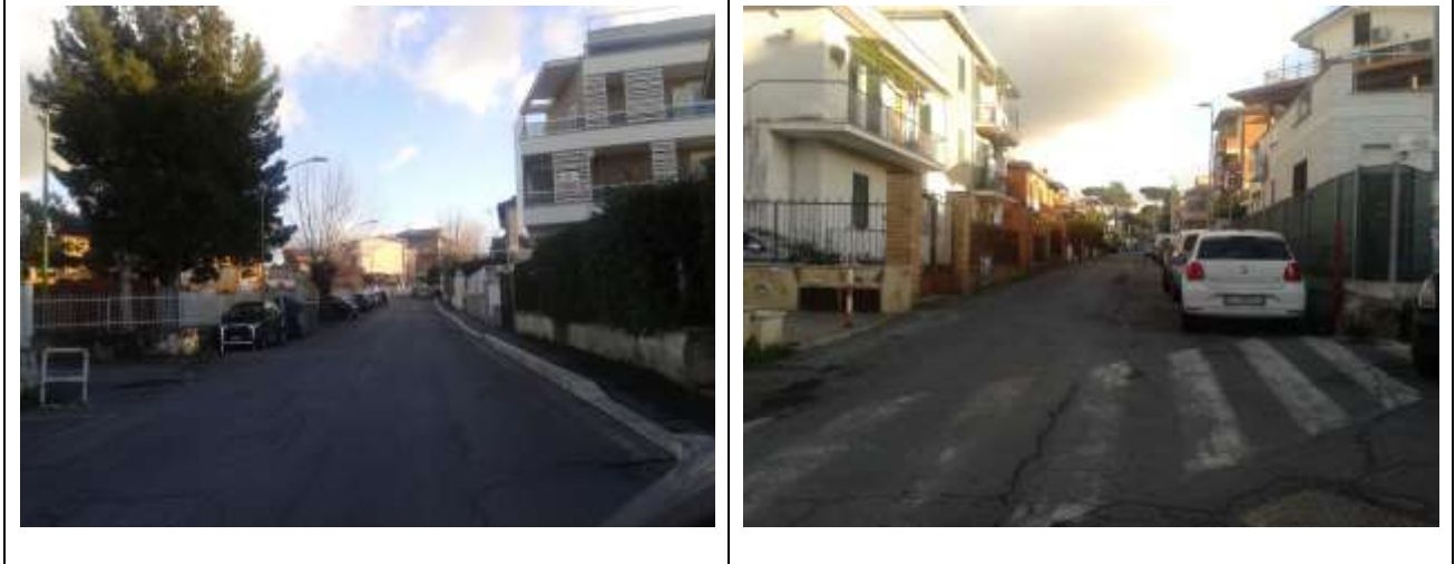
Foto 14: S.M. delle Mole Area est - viabilità principale
